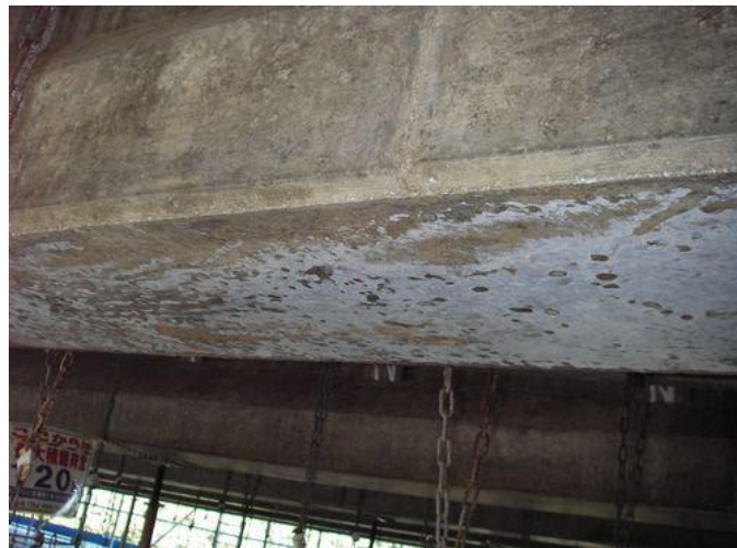
事例写真 (既設構造物への施工事例)
