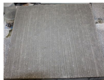
写真5 コンクリート版
