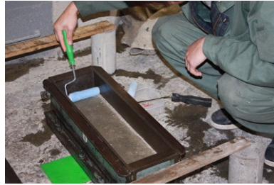
写真2 打継ぎ面への塗布状況
