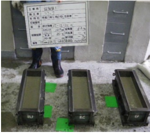
写真1 1層目打設状況
