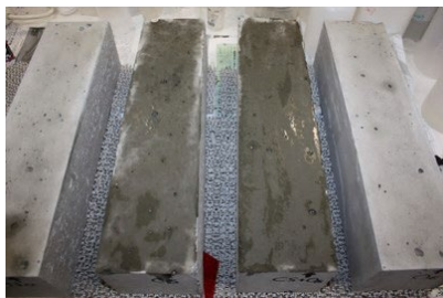
写真1 コンクリート養生剤塗布状況
