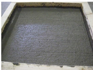
写真3 基板の打設状況
