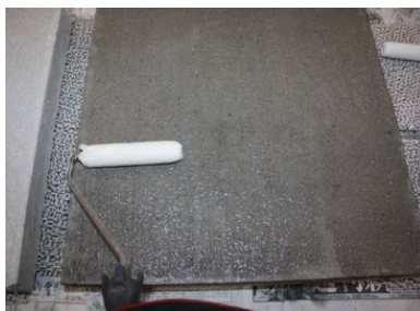
写真4 表面含浸材塗布状況
