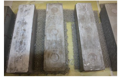
写真3 表面白化状況 (けい酸塩系表面含浸材塗布7日間後)
