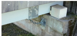
橋台の桁受け部
