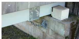
橋台の桁受け部
