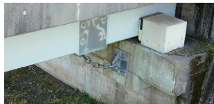
橋台の桁受け部
