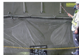
R側 塗布後
