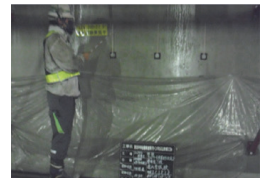
L側 塗布後
