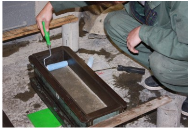
写真2 打継ぎ面への塗布状況
