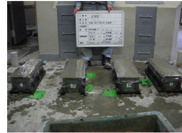
写真3 2層目打設状況
