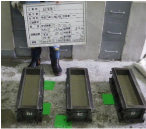
写真1 1層目打設状況
