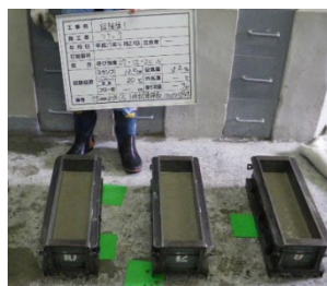
写真1 1層目打設状況
