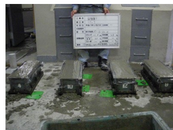
写真3 2層目打設状況
