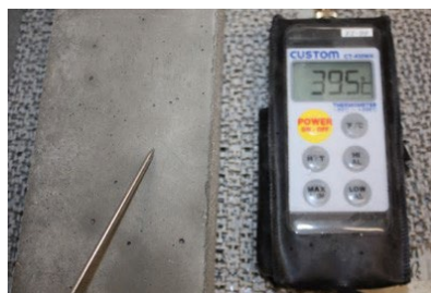
写真2 散水養生後温度 (39.5 °C)
