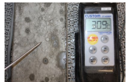
写真3 含浸材塗布後温度 (30.9 °C)
